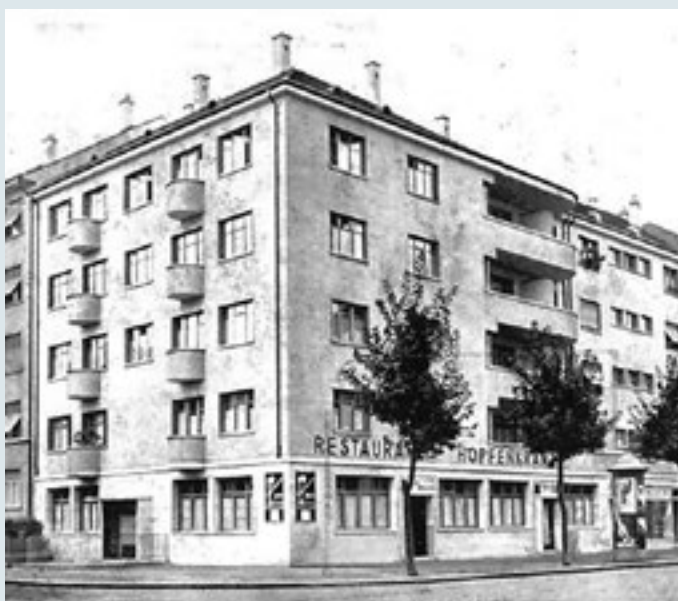
■ Das Restaurant Hopfenkranz lag an der Allschwilerstrasse in Basel.
