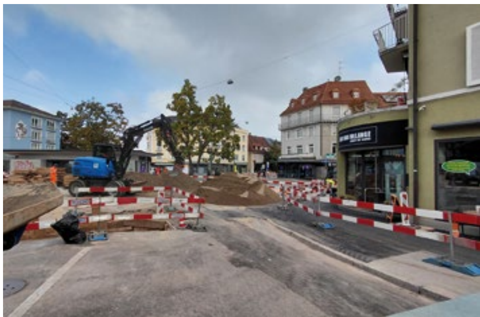
Die Baustelle am Neuweilerplatz führt zu massiven Umsatzeinbussen in den umliegenden Geschäften.
